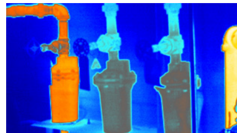
暖通空调检修
